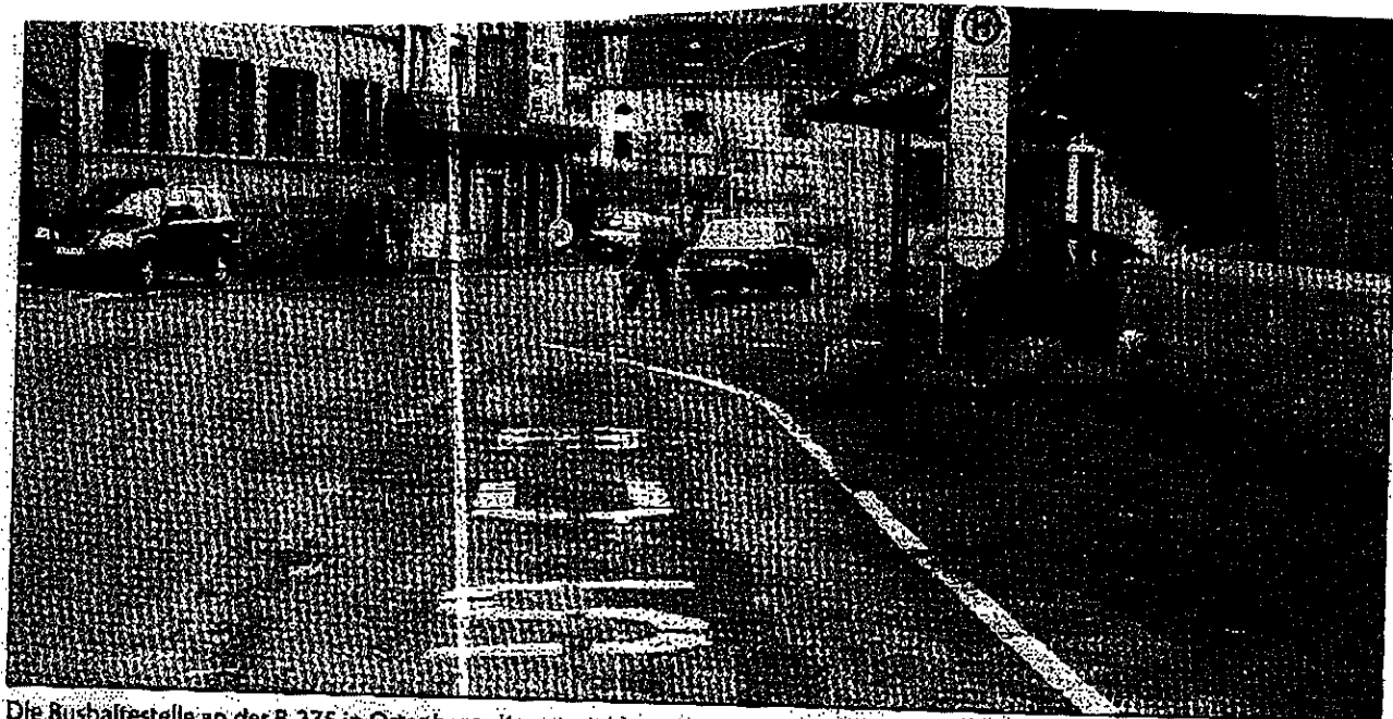
Die Bushaltestelle an der B 275 in Ortenbergs Kernstadt birgt einige Gefahren für Fußgänger und andere Verkehrsteilnehmer, da Gehsteig und Fahrbahn ineinander übergehen und auch Linien nicht eindeutig zu erkennen sind. Bild: Neumann
